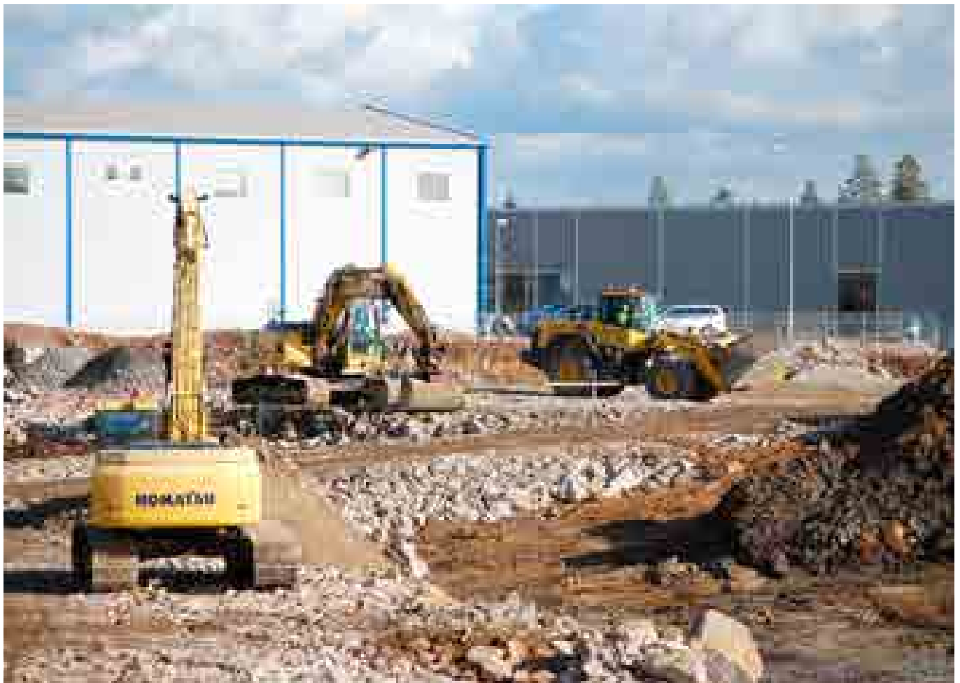
Ilvesvuori on ollut alati jatkuvaa rakennustyömaata.
